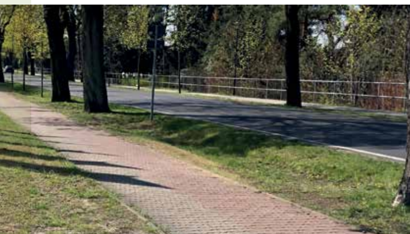
Eine der wichtigen Verbesserungsmaßnahmen für die Infrastruktur der Wandlitzer Zukunft: der Ausbau eines Radwegenetzes im gesamten Gemeindegebiet. (Foto: Radweg in Basdorf, Uwe Liebehenschel)
