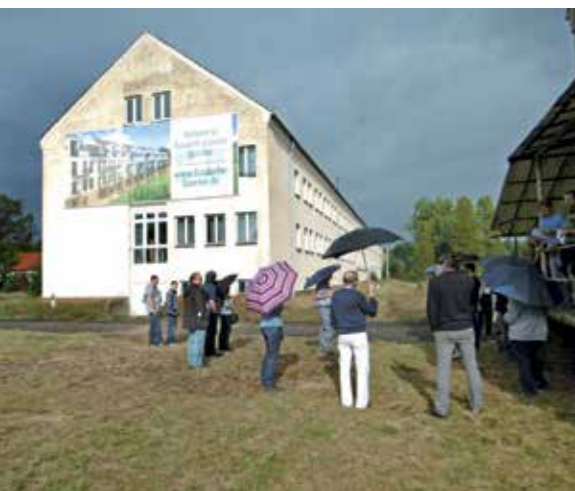
Die Basdorfer Gärten: 2014 erstellte Oliver Borchert (Bauingenieur für Architektur) eine Machbarkeitsstudie für den Umbau der Kasernenblöcke in attraktive, preisgünstige Wohnungen. Im Bild rechts die Gebäude im Umbau, im April 2020 zogen die ersten neuen Mieter ein.
